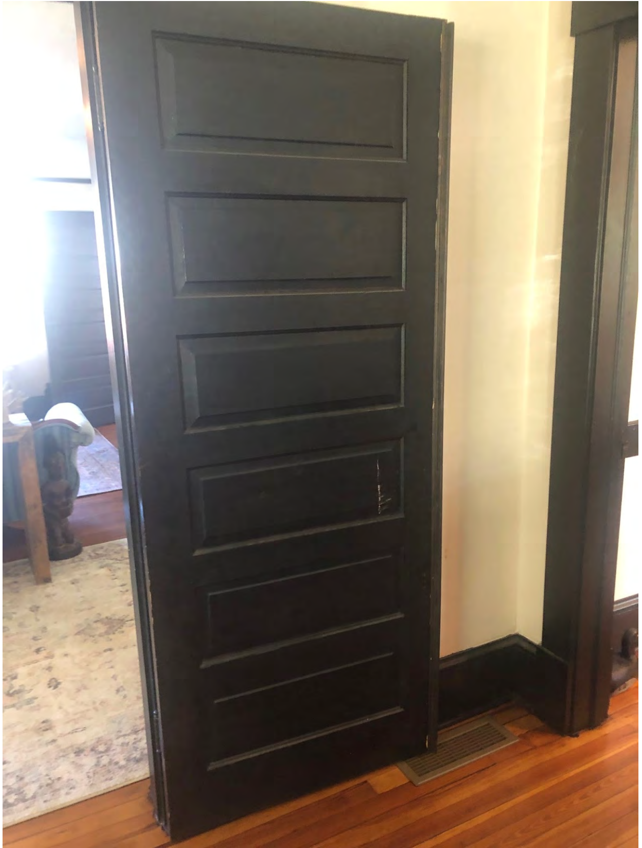
18. Paneled Wood Door
